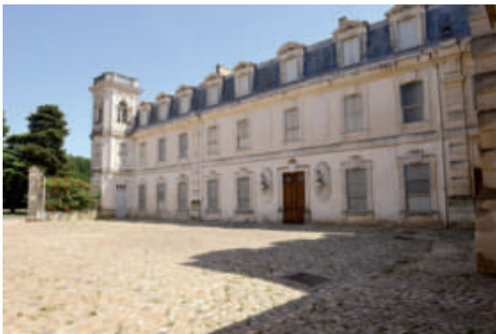
Façade nord du château.
