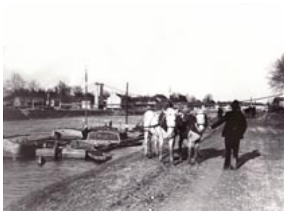
Les coches d'eau pouvaient être tractés par des chevaux qui longeaient les chemins de hallage.
